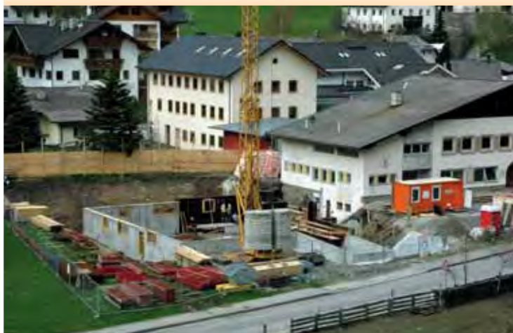
Die Fundamente sind fertig gestellt.
