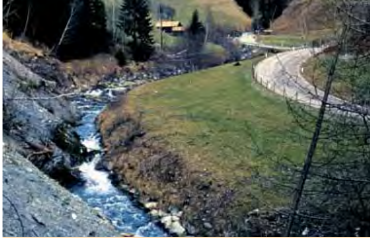
Riesiger Hangrutsch im Bruch-Wald , 2001
