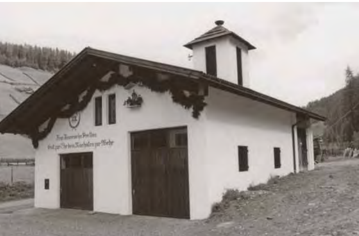
Hallenanbau an der Südseite, 1982
