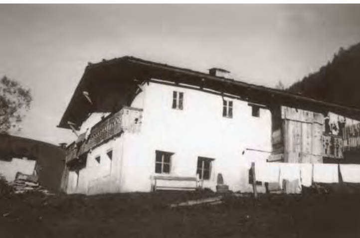
... und verschüttet den Untoolprech-Hof .
