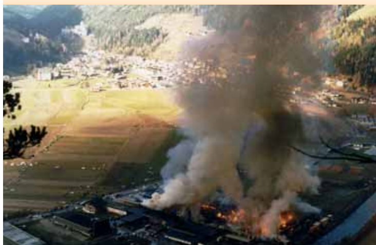
Großbrand im Firmengebäude Lacedelli , Sand in Taufers 1981
