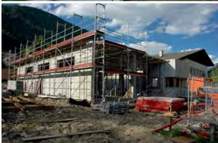
Das neue Feuerwehrhaus nimmt Gestalt an.
